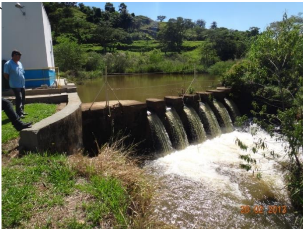
Foto 4.1 – Detalhe da Barragem no Ribeirão da Prata
