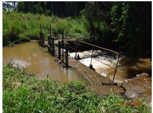
Foto 4.11 – Detalhe da Barragem no Rio da Fartura
