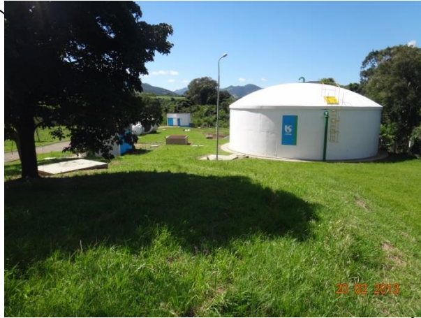
Foto 4.5 – Reservatório Apoiado RA02
