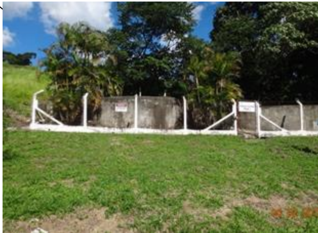
Foto 4.18 - Fossa Filtro VNSA
