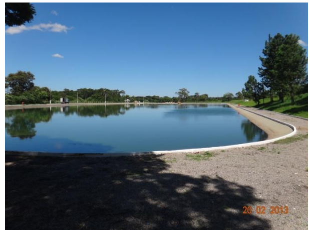
Foto 4.17 - Vista Geral Lagoa Facultativa
