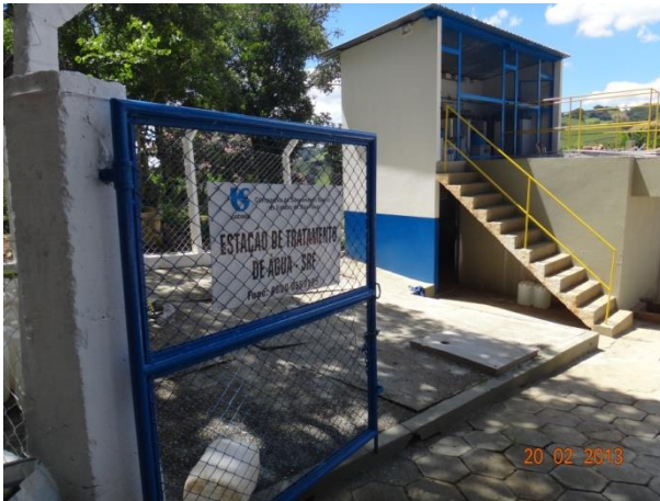
Foto 4.12 – Vista Geral da ETA SRF
