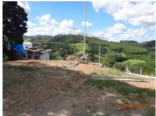
Foto 4.15 – Acesso à ETA Cascata
