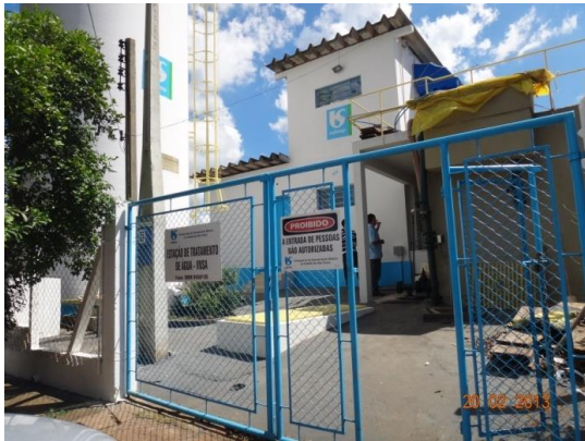
Foto 4.7 – Vista Geral da ETA
