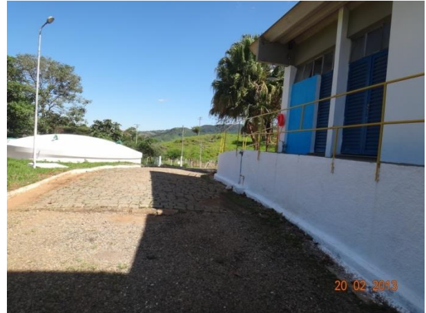
Foto 4.4 – Vista lateral de ETA e Reservatório
